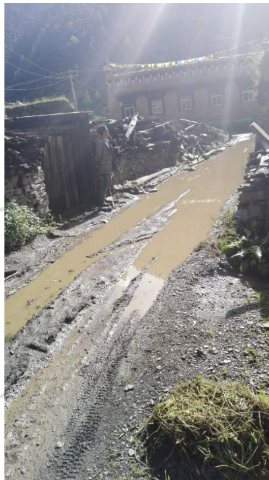
整修前的道路
