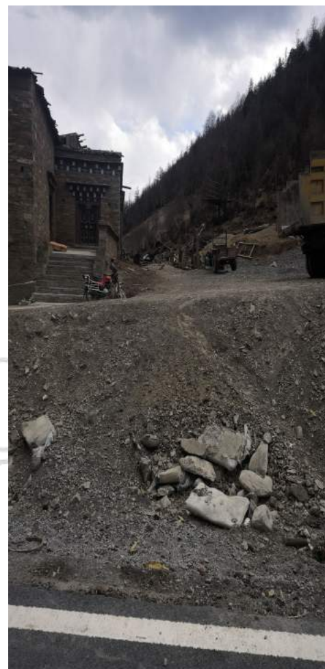
整修前的房前
